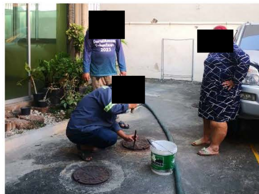
ภาพที่ 2.2-11 การสูบล้างระบบบำบัดน้ำเสีย
